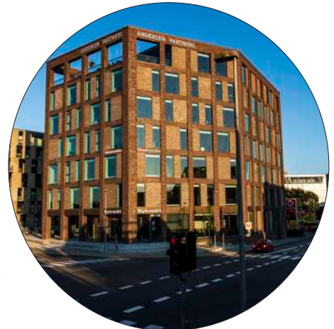
Foto - Nyt kontorbyggeri ved Campusområdet.
